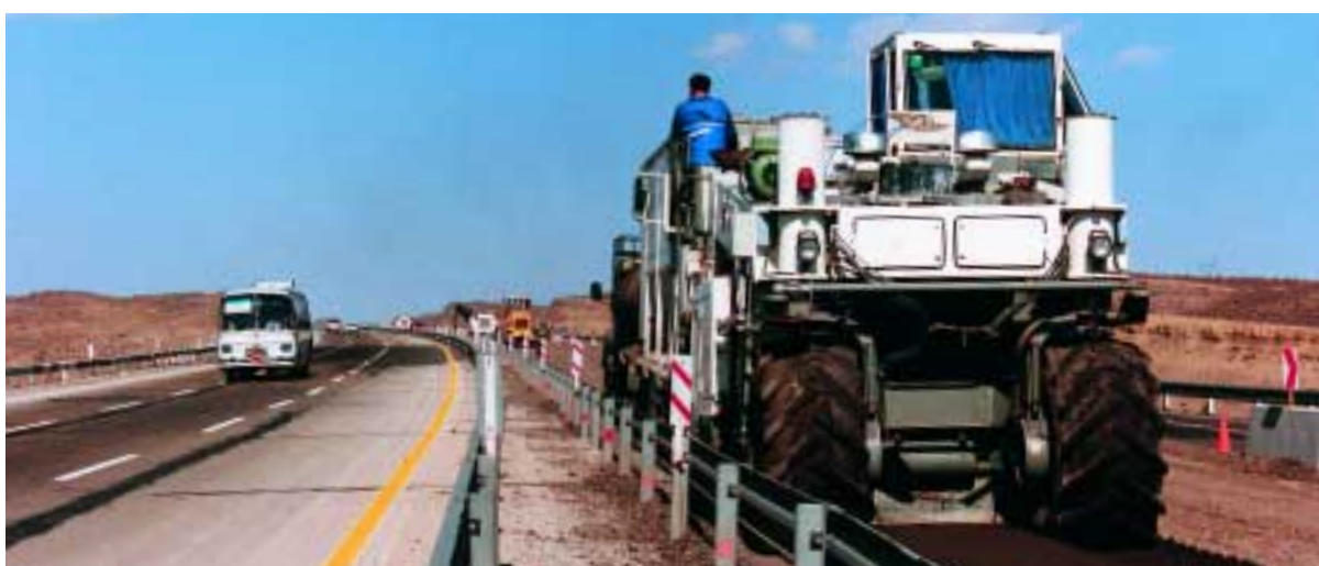
En la rehabilitación de una autopista en el Irán, la máquina WR 2500 pudo demostrar, una vez más, su eficiencia. Después de haber fresado partes de la capa de base, la máquina comenzó muy eficazmente con su trabajo de reciclado.
