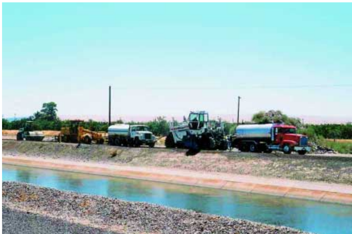
El tren de reciclaje con la máquina WR 2500 trabajando a lo largo de la red de canales en el distrito Los Baños: en el futuro, las vías de canal serán aptas para el tráfico, incluso de vehículos agrícolas pesados.
