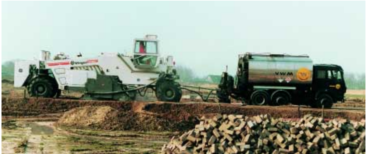
Trabajos de saneamiento de carreteras en los Países Bajos: La recicladora WR 2500 va empujando el carrotanque de betún, en el cual se almacena el betún caliente.
