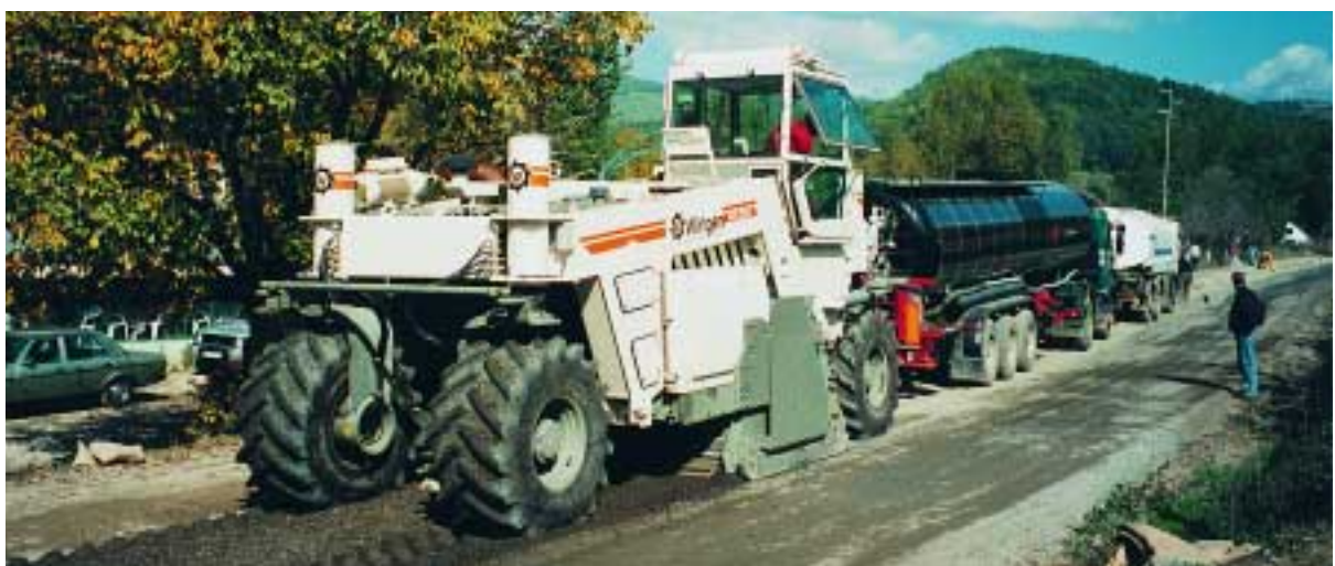
En esta obra se esparció cemento antes de que la máquina WR 2500 comenzara a trabajar: debido a su potencia, es capaz de empujar con facilidad el carrotanque de agua y el carrotanque de betún, durante el proceso de tratamiento.
